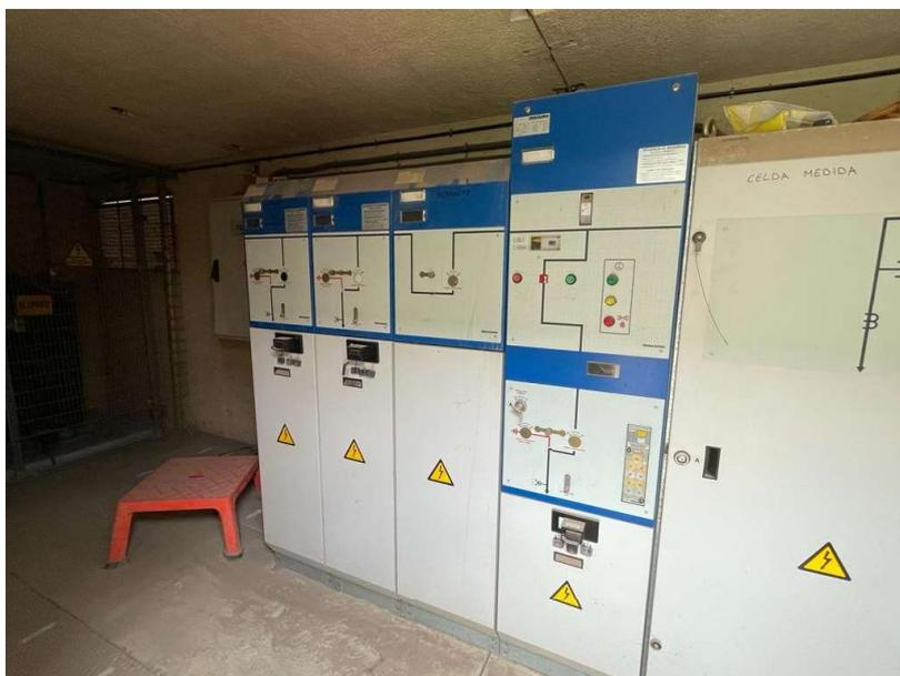
Fotografía 4. Vista general celdas protección alta - conexión trafo.
